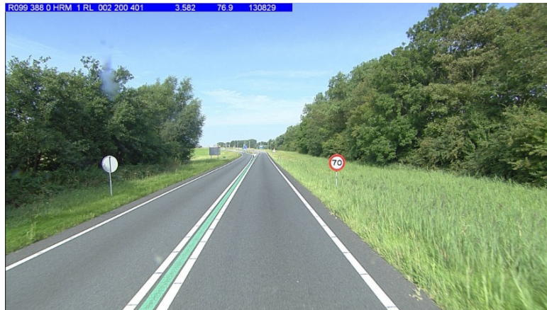
Figuur 11. Impressie van een conflicterende situatie tussen bebording en markering. De weginrichting (groene markering in de rijrichtingsscheiding) suggereert een snelheidslimiet van 100 km/u. Het verkeersbord geeft een snelheidslimiet aan van 70 km/u i.v.m. naderende bocht. Automobilist en voertuig moeten deze situatie op de juiste manier interpreteren.
