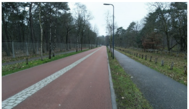
Figuur 5. Te krappe rechtstanden zijn over het algemeen niet geschikt voor LKA en ALKS. Voor een toekomstvast ontwerp is het scheiden van modaliteiten over het algemeen veiliger dan mengen.
