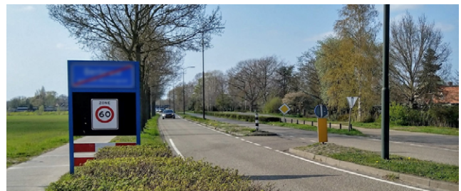
Afbeelding 9: Zone 60 op een weg met gescheiden rijbanen en vrijliggende fietspaden is niet conform CROW. (Zie CROW publicatie Basisinformatie/Basiskenmerken wegontwerp - Categorisering en inrichting van wegen, paragraaf 1.1.6 Veilige snelheden en geloofwaardige snelheidslimieten)
