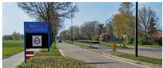
Image 9: Zone 60 on a road with separate lanes and separate bicycle paths does not conform to CROW. (See CROW publication Basisinformatie\Basiskenmerken wegontwerp - Categorisering en inrichting van wegen, paragraaf 1.1.6 Veilige snelheden en geloofwaardige snelheidslimieten).
